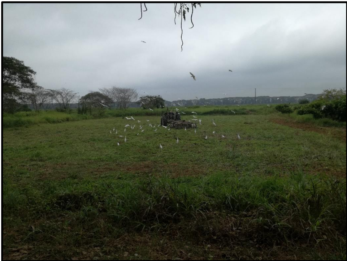
Fig. 2. Preparación de terreno
