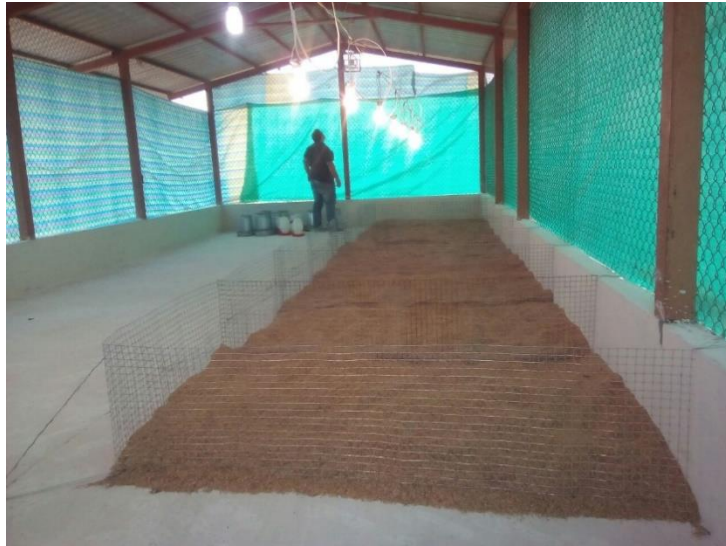
Revisión de instalaciones eléctricas
