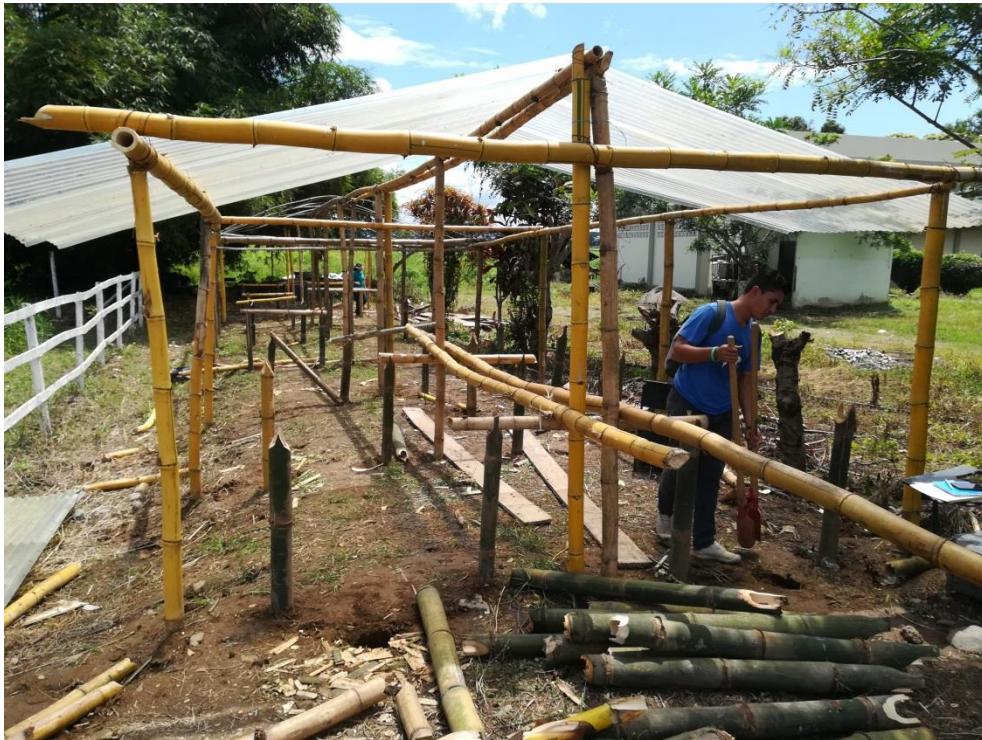
Figura 5. Construcción del invernadero.
