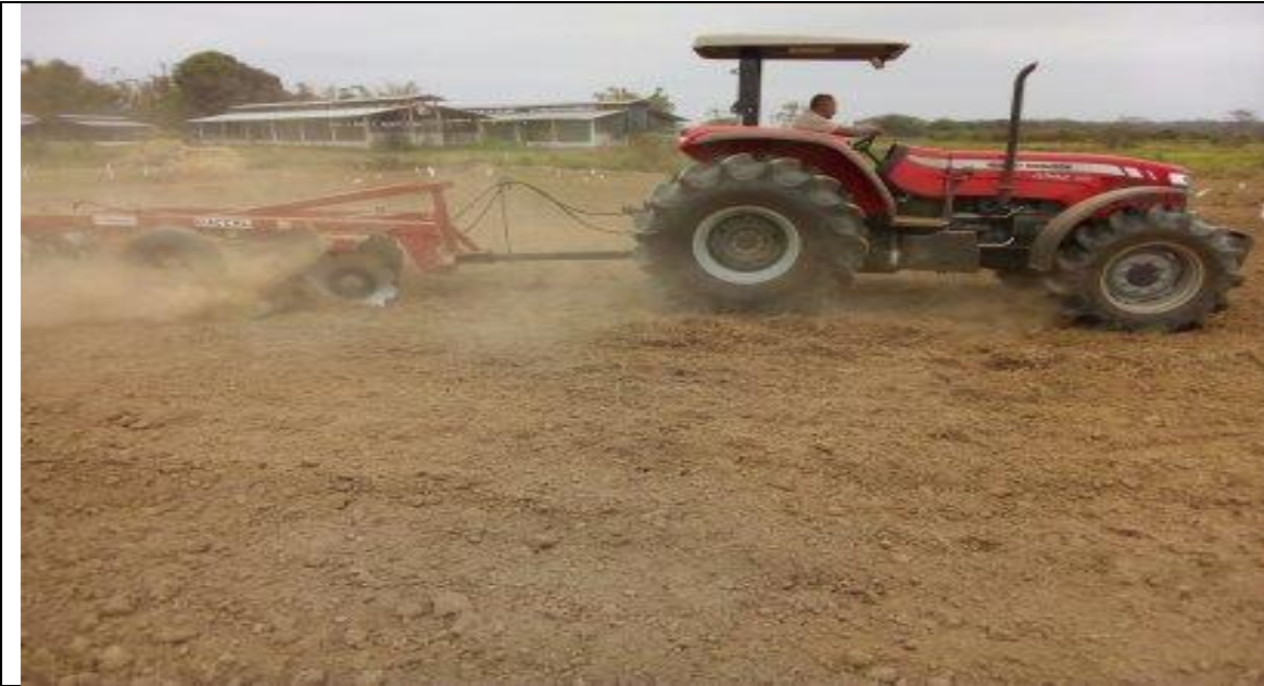
PREPARACION DEL TERRENO
