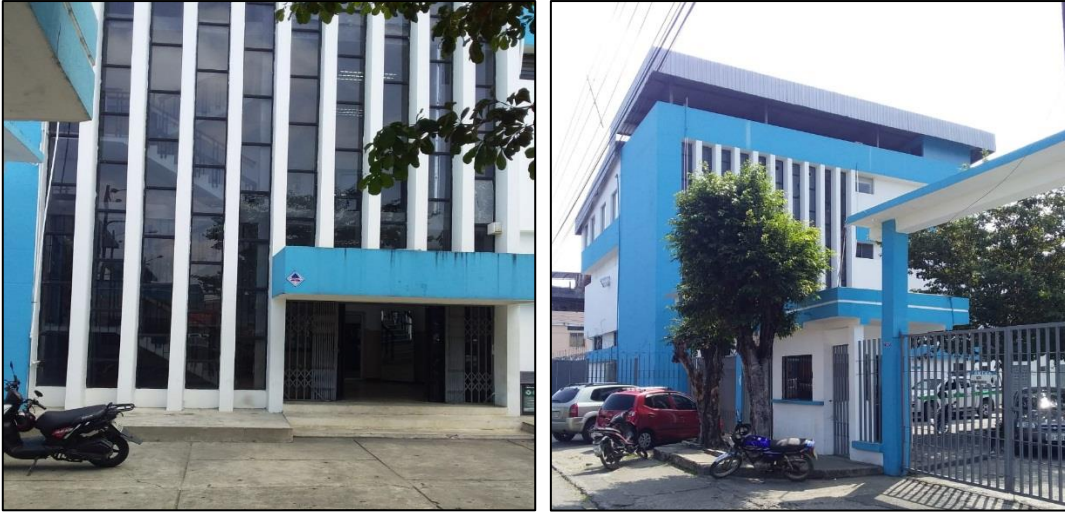
Foto N°1: Edificio Principal CNT
