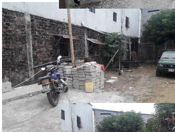
Aspecto de la bodega externa donde almacenan materiales de forma inadecuada y sirve de estacionamiento de vehículos
