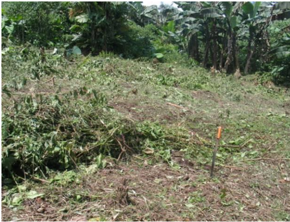
Fig. 1 Desbroce de terreno
