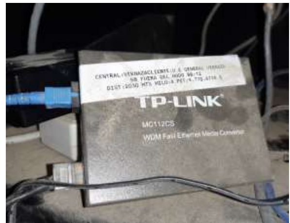
Foto6: WDM convertidor de medios de Ethernet rápido (Fibra óptica)
