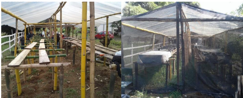
FIGURA 2. CONSTRUCCIÓN DEL INVERNADERO
