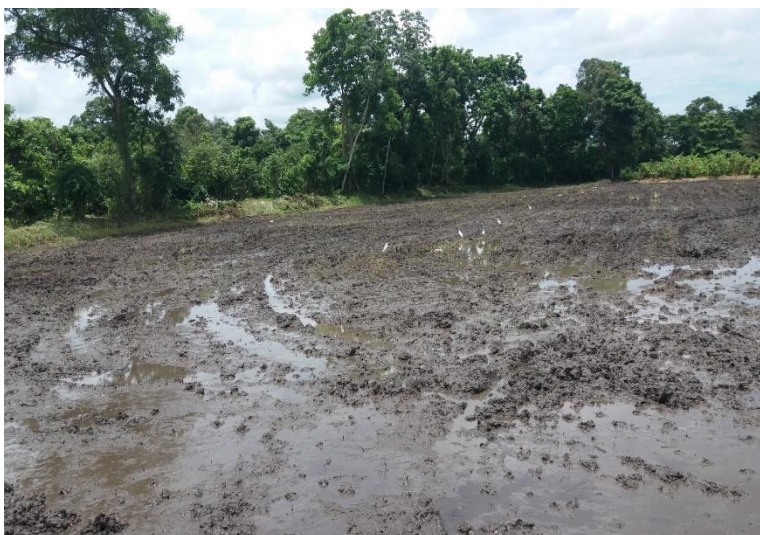
Figura 1. Preparación de terreno.
