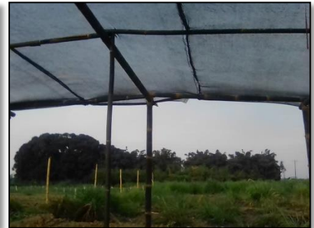
Ilustración 12. Colocación de sarán lateral y techo
