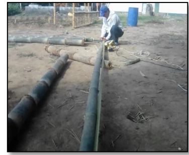
Ilustración 11. Medición de cañas entre 5 m (techo) y 3m (laterales)
