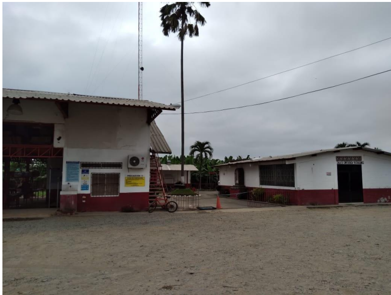
Ingreso a las instalaciones de la Hcda. Dan Luis
