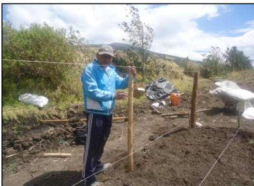
Figura 10. Elaboración de micro túneles 1.
