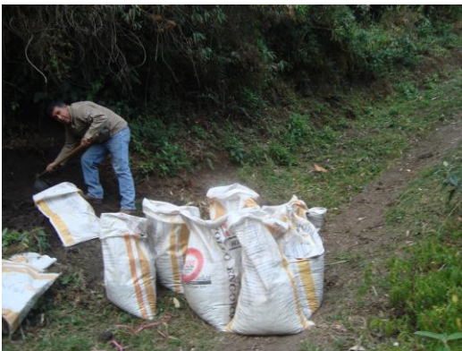
Fig. 5. Minada de tierra
