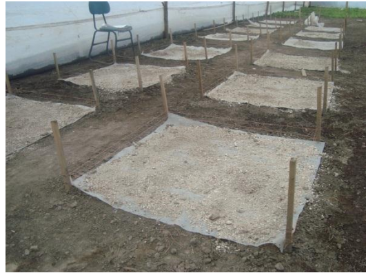
Fig. 11. Colocación de cascajo
