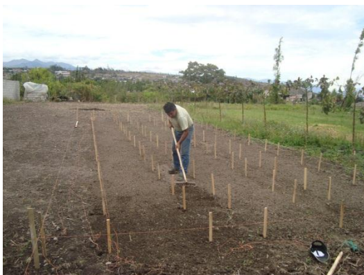
Fig. 6. Rastrillado y nivelación del suelo
