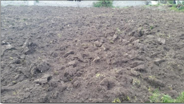
Figura 03.- Preparación del terreno.
