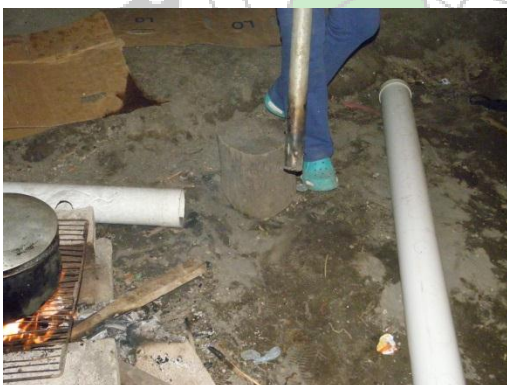
Figura 3. Perforación hoyos en PVC.
