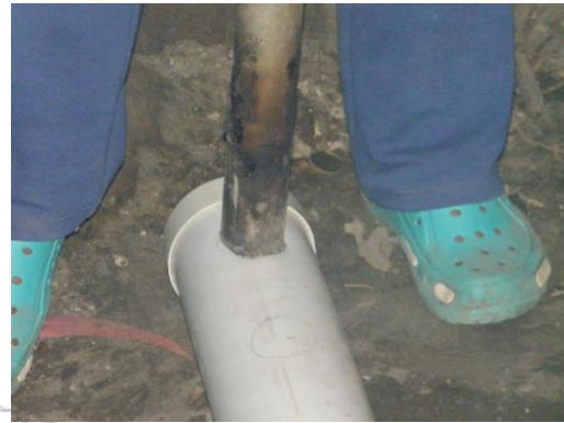
Figura 4. Perforando tubo de PVC
